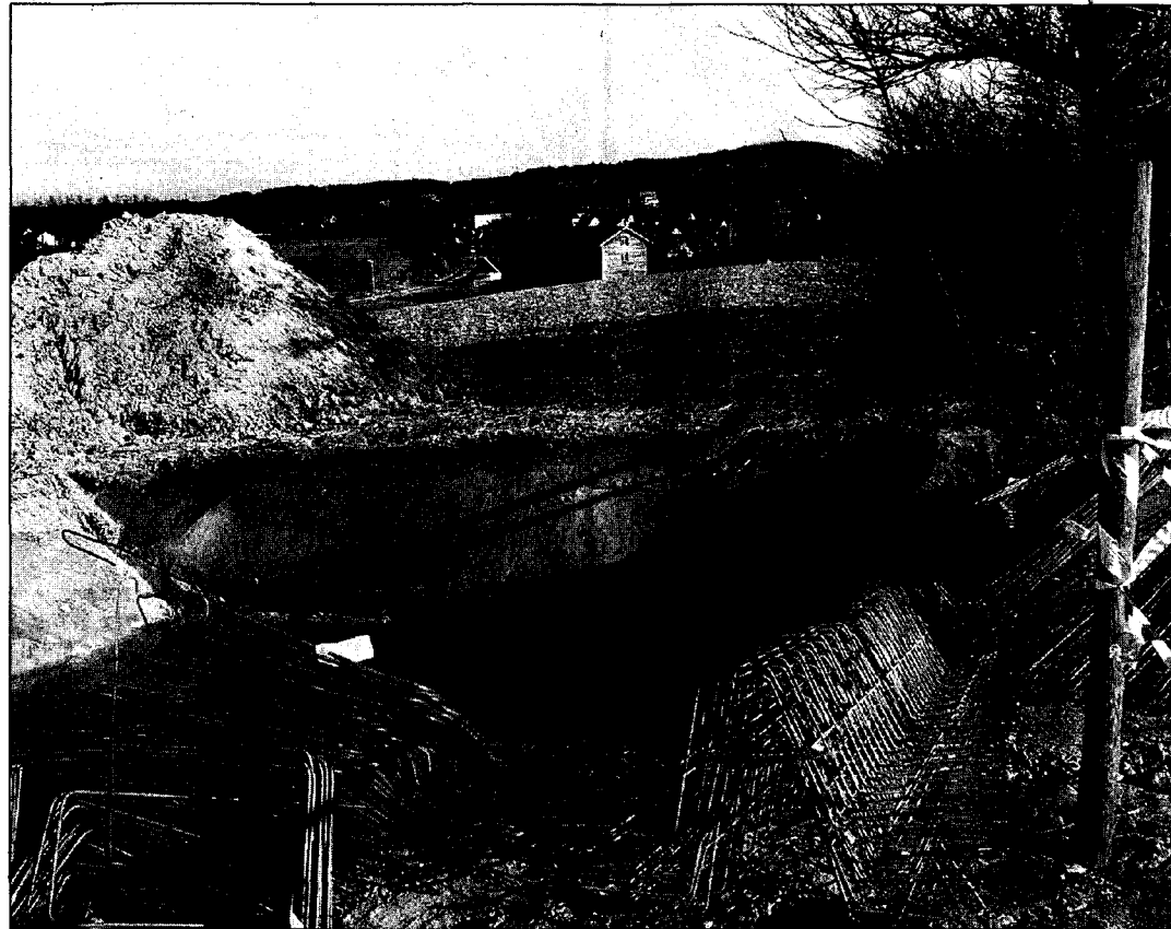
DIE BAUGRUBE ist ausgehoben und die Grundierung für das Fundament gegossen. Doch nun ruht die Baustelle am Menzinger Ortseingang, wo ein Mobilfunkmast errichtet werden soll. Foto: hf
